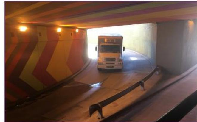
Figura 6-16. Curva horizontal con sobre ancho
