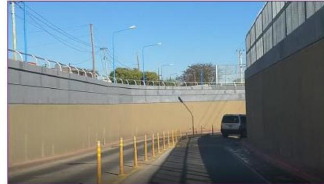
Figura 6-15. Muro lateral limitando visión en curva
