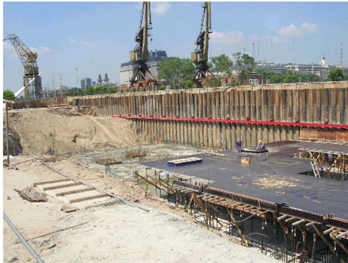
Muro de Sostenimiento – Puerto Madero
